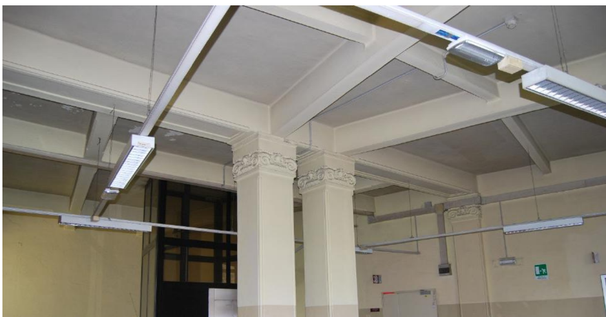
Figura 4, solaio dell'atrio all'ultimo piano del corpo affacciato su piazza Robilant. In evidenza le caratteristiche nervature a raggera
