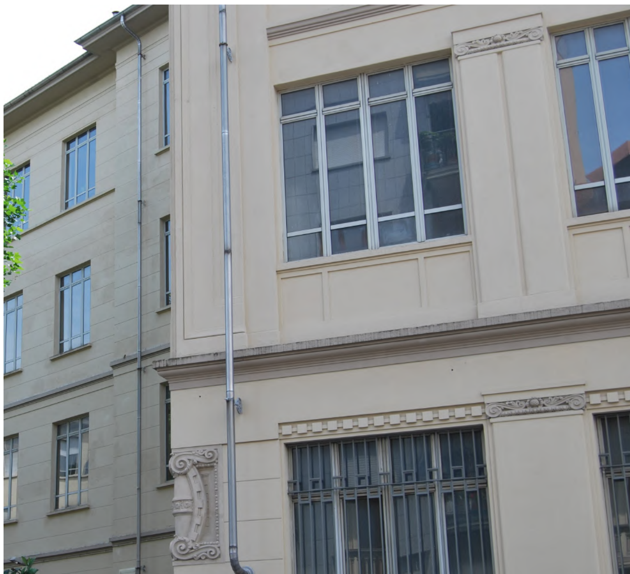
Figura 2, porzione di facciata su via S. Paolo. In primo piano le decorazioni.
